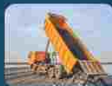
OPTIMIZACIÓN DEL USO DE MATERIALES, VENTILACIÓN DE CASCOS Y GESTIÓN RESPONSABLE DE RESIDUOS DE OBRA.
