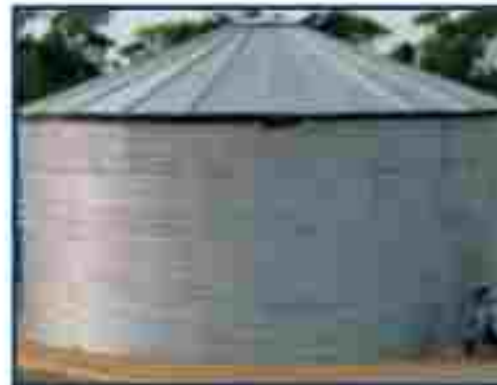
Tanques tipo australiano
