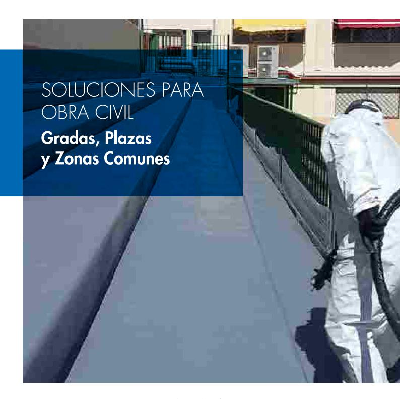
Los sistemas **DANOCOAT®** para impermeabilización y protección de diferentes estructuras de edificación permite reducir y eliminar el deterioro de los soportes provocados por agresiones físicas y químicas de agentes externos, son meteorológicos o no, prolongando así la vida útil de las estructuras y facilitando la conservación de las mismas.
