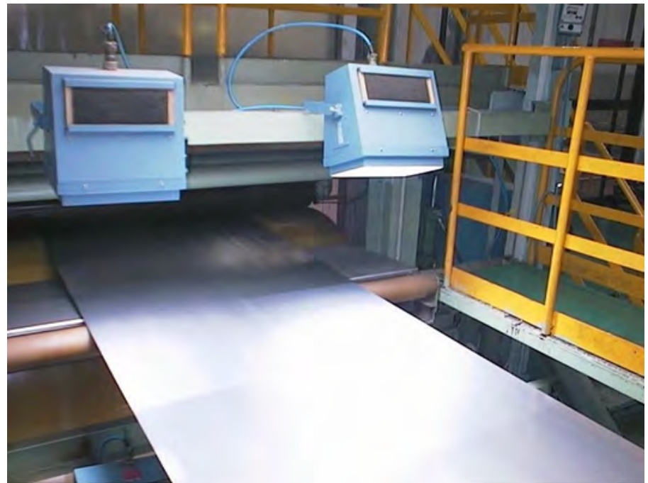
Inspección de superficie en papel y lamina metálica
