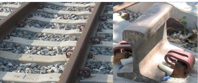
AISLADORES: Fabricados en policarbonato, para garantizar las comunicaciones a través del riel.
