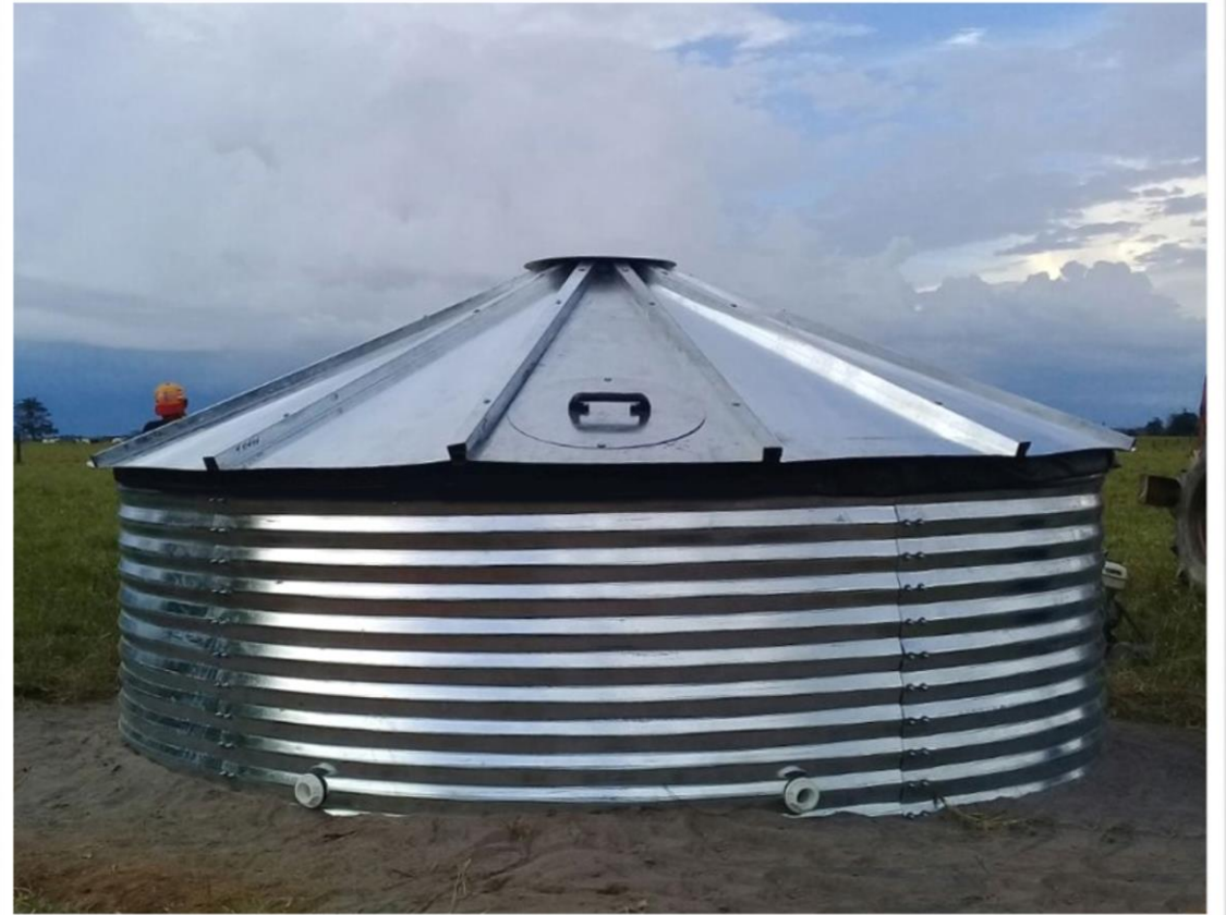
Acueductos rurales (Tanques para almacenamiento de agua potable)
