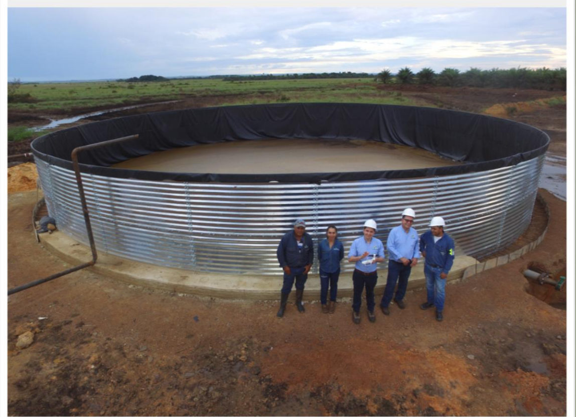
Tanques para almacenamiento de lixiviados ( Residuos de la producción agro-industrial)
