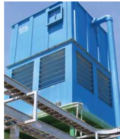
TORRES DE AIREACION
