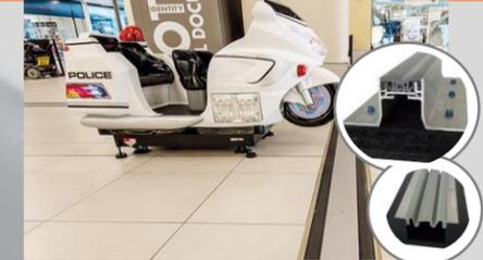
Proporcionan una cubierta en toda la abertura de la junta de expansión, sin que resulte afectada por el movimiento relativo de las dos superficies a cada lado de la junta. Las juntas de expansión van por toda la estructura del edificio, desde la parte superior a la inferior, desde la parte delantera a la trasera.
