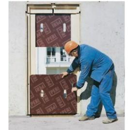
Complemento de los encofrados de muro para obtener rasgos de ventanas y puertas perfectas sin alterar la modulación eficiente de encofrado.
