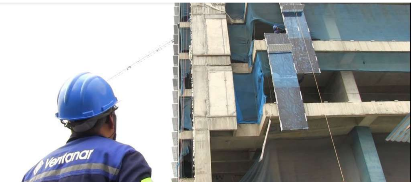
Izaje de paneles
