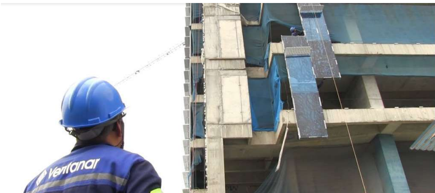
Izaje de paneles
