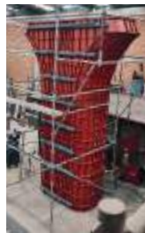
Armado pila puente Av. Boyaca / Calle127
