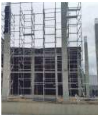
Apuntalamiento para vigas
