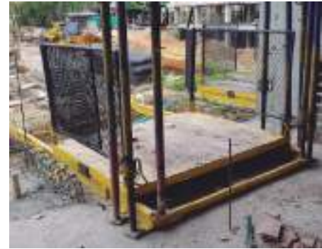
Plataformas para cargue y descargue de materiales
