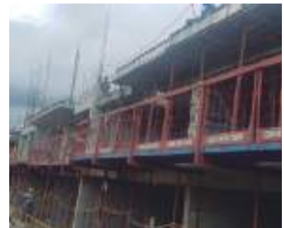
Pasarela de trabajo Rua Group
