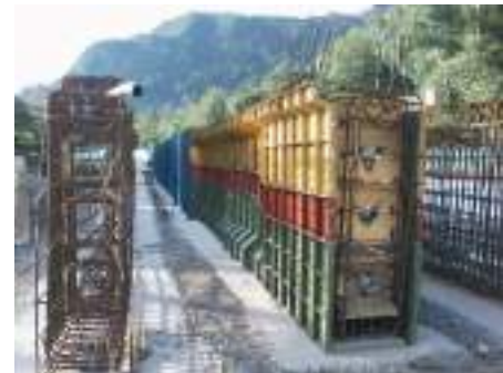
Vigas para puente - Vigas postensadas
