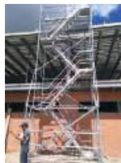
Torre de acceso
