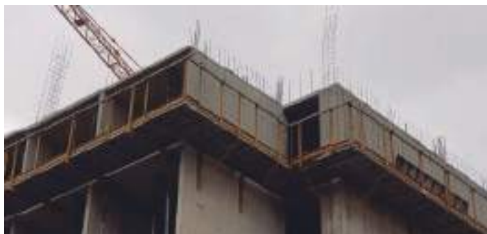
Pasarelas AR construcciones - Fontana / Madrid
