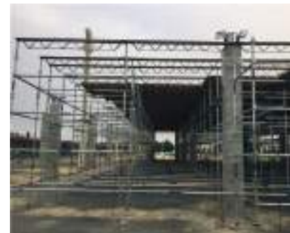
Torre o cimbra de apuntalamiento
