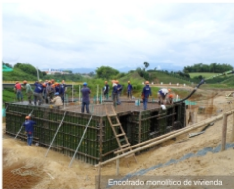
Encofrado monolítico de vivienda
