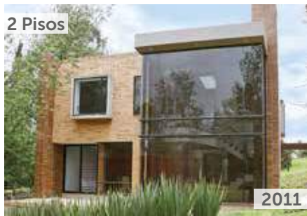
TORRELADERA BOSQUE RESERVADO CASAS 1 Área total construida: 7.559 m 2 Carrera 80 No. 151-31 NSE: 6 Unidades de vivienda: 28
