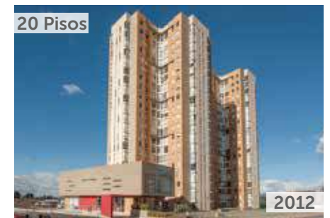
CIUDADELA PARQUE CENTRAL DE OCCIDENTE 2 Área total construida: 60.370 m 2 Calle 77B No. 129-70 NSE: 4 Unidades de vivienda: 640
