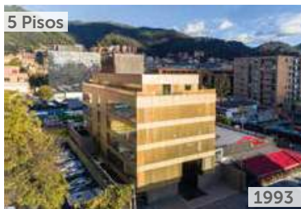
EDIFICIO OFICENTER 93 Área total construida: 3.500 m 2 Carrera 14 No. 93A-30 NSE: 6 Unidades de oficina: 40
