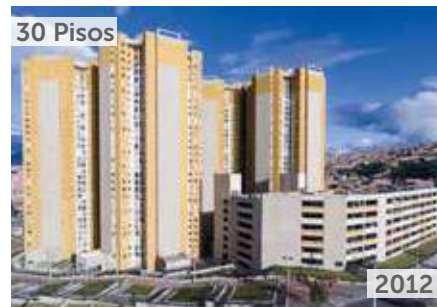
TORRES DE BELLAVISTA Área total construida: 125.327 m 2 Transversal 70D Bis No. 68-75 Sur NSE: 3 Unidades de vivienda: 1.500
