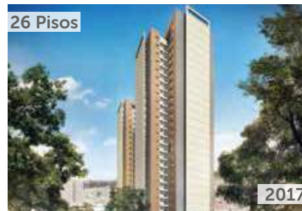
CERROS DE SUBA Área total construida: 23.780 m 2 Avenida Carrera 91 No. 128A-90 NSE: 2 Unidades de vivienda: 404
