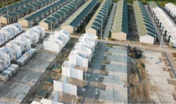
300 viviendas nucleadas 40,50 m2 Olaya Herrera, Nariño. 2016 10 meses de construcción
