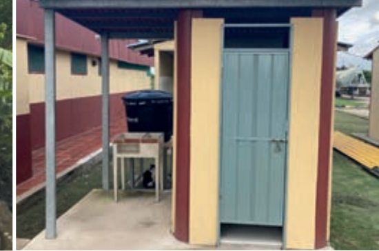
Batería Sanitaria con Recolección de Aguas Lluvias. Barranquilla, 2020
