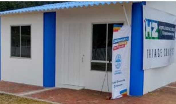
Módulos Triage 42,30 m2, Cundinamarca, 2020 - Armado en 72 horas de trabajo
