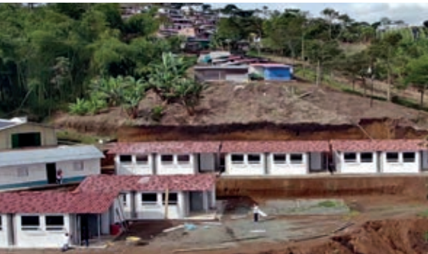
Salón Múltiple 53 m2 Área Rural, Risaralda. 2022 10 días de trabajo para la construcción
