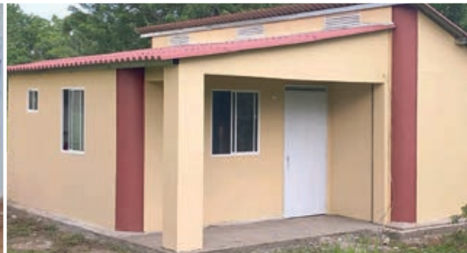
Vivienda Rural Dispersa 55 m2 15 días de construcción. Putumayo, 2022
