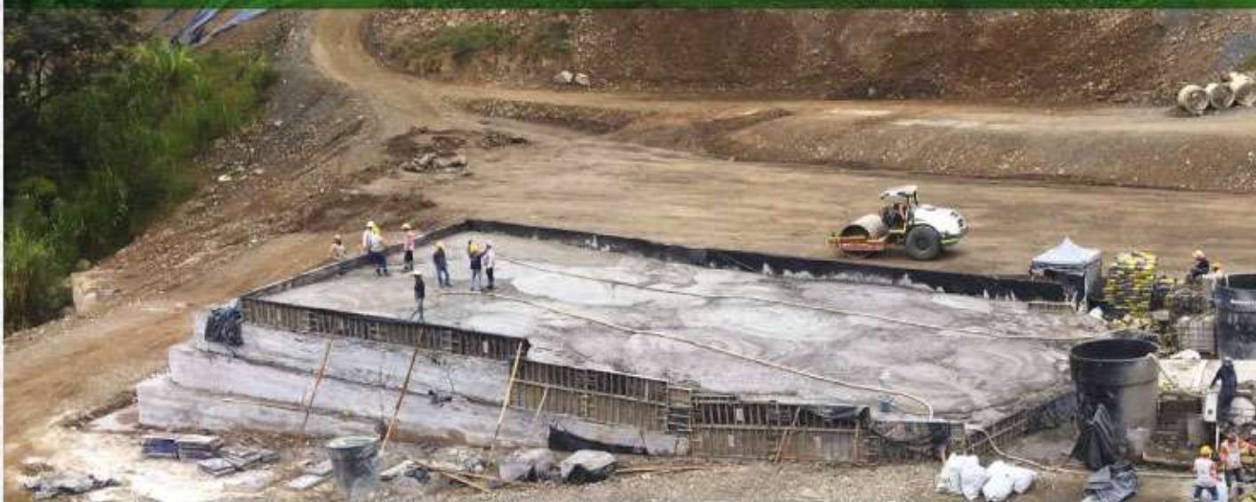
Terraplén Puente 14 doble vía Medellín - Manizales
