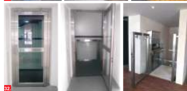
Ascensor media cabina con estructura
