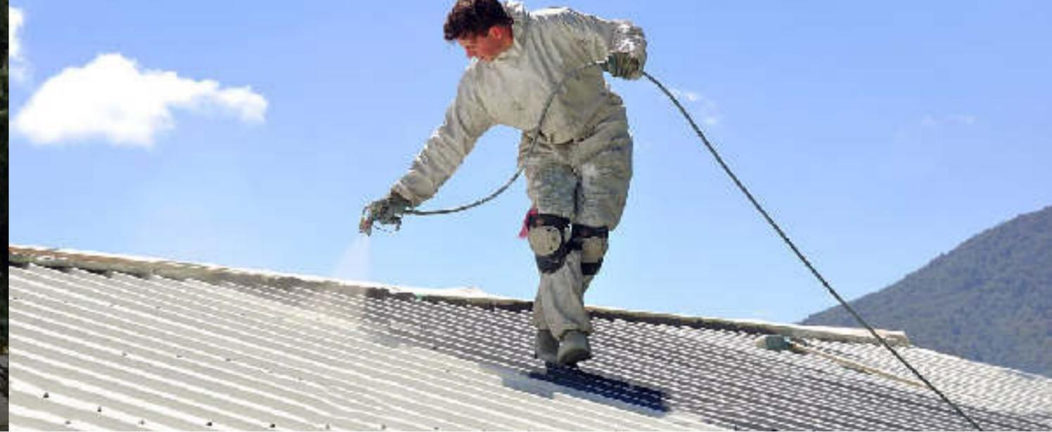
ThermaCote® es un producto versátil, efectivo y estético el cual se aplica por medio de pulverización con un sistema *airless*, garantizando una aplicación uniforme a lo largo de la superficie.
