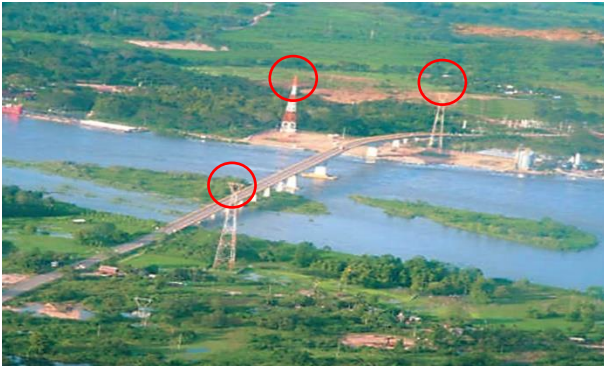
PDCE-DDCE instalado en ECOPETROL – Torres de transmisión eléctrica Puente Yondó - Colombia
