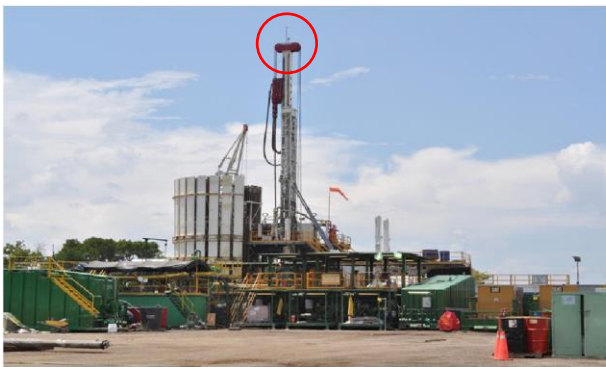
PDCE-DDCE instalado en PETREVEN – H201 Cantacallo - Cobia
