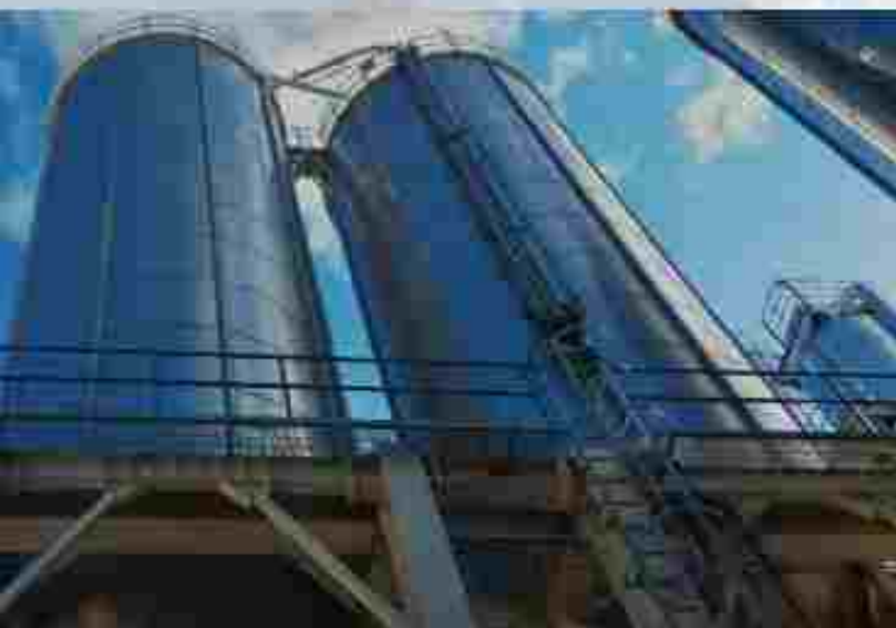
Sistema de transporte en línea directa de pallets de plástico para alimentación de silos de proceso
