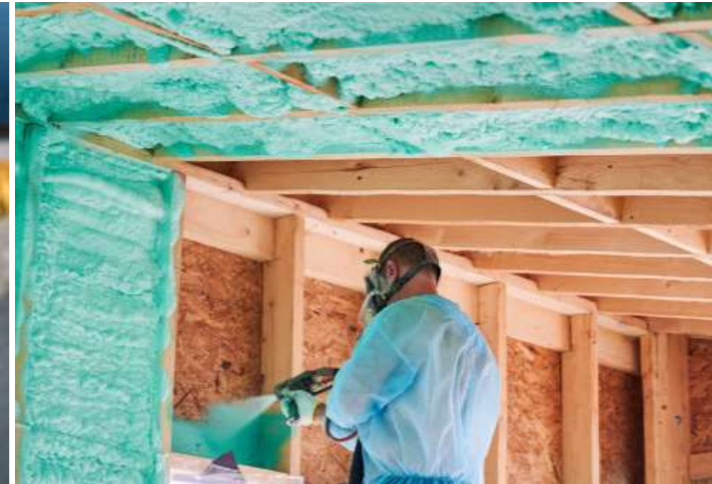
Aislamiento continuo, sin uniones ni fisuras
