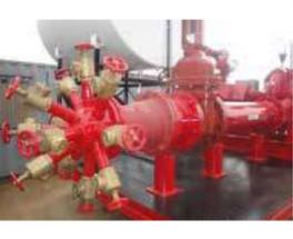
Suministro de EQUIPOS DE BOMBEO tipo carcaza partida, succión final, turbina vertical, captación de mar para sistemas contra incendio, certificados UL y FM cumpliendo con la norma NFPA 20.
